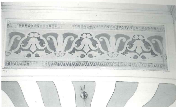
Villino Dini. Particolare della decorazione esterna.
