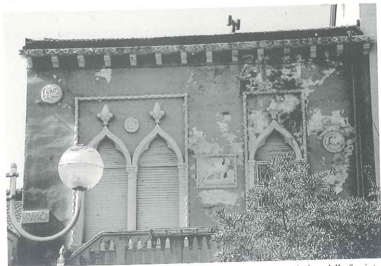
Casa Breschi. Particolare della facciata.
